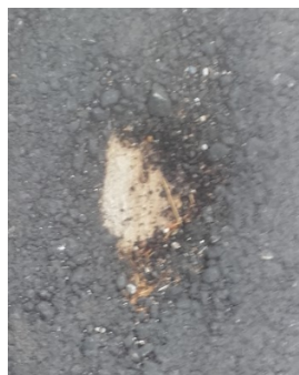
- in Strasse vergessenes Holzteil
