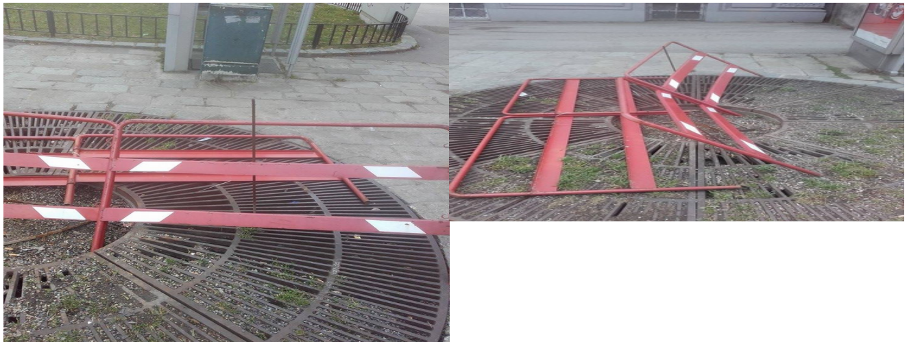
Leere Baumscheiben mit desolatem „Schutz“ bei 51A Station Cumberlandstrasse (Höhe Einwagg.33/35)
