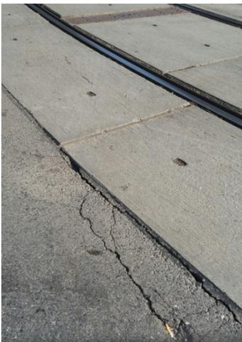
Die Schäden am Asphalt der Linzerstrasse im Bereich Nr. 428 / Endstelle Linie 49 lassen im Kurvenbereich der Linie 49 schon die Betonplatten absinken. Um weitere Schäden zu verhindern gehört das überprüft und repariert.
