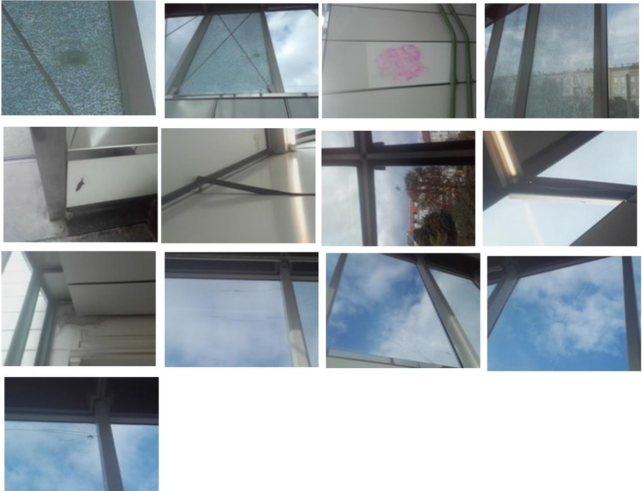
Diese Fotos, aufgenommen in den Stationsbereichen der U4 Braunschweigasse, Unter St. Veit, Ober St. Veit sowie Hütteldorf zeigen die offensichtlichsten Schäden: Lockere Dichtungen, lose Kabelverschalung, eingeschlagene, gesprungene Fenster, bröckelnde Mauern, etc.
