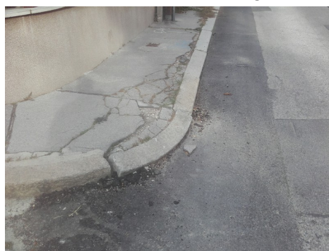
Von Baufahrzeugen zerstörte Gehsteigkanten, z.B.: Ecke Sambeckgasse 26
