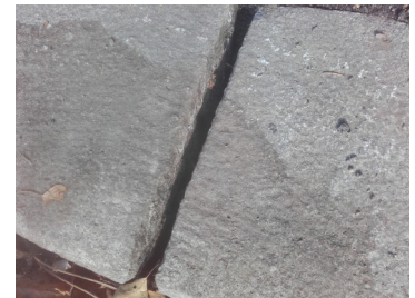
Nicht gefüllte Spalten zwischen Randsteinen, Heinrich-Collinstr.#Zettelweg
