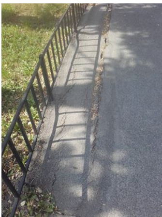
(Foto 1: abgesenkter Gehsteigteil, Foto 2+3: Riss im Gehsteig)
