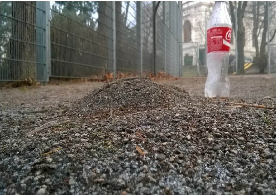
Ballsporthof ALT: Gefährliche Wölbungen – Verletzungsgefahr!
